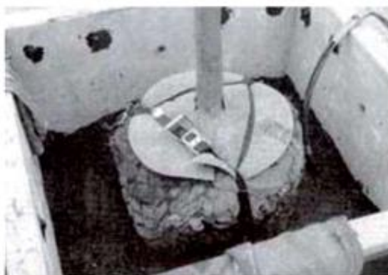
Σχήμα 7 - Υπεδάφια στήριξη δένδρου με χρήση γεωπλέγματος
