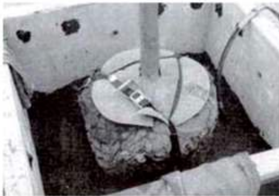
Σχήμα 7 - Υπεδάφια στήριξη δένδρου με χρήση γεωπλέγματος
